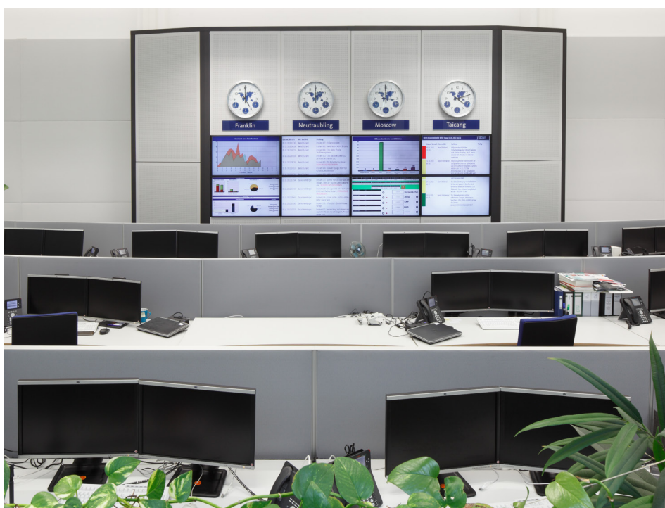
▲ Velkoprostorová kancelář se SonoPerf akustickými elementy
