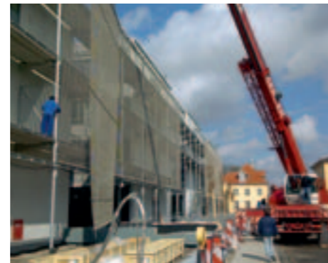
Ein Blick hinter und auf die Fassade demonstriert: Die flexible Montage ist keine Zerreißprobe.
